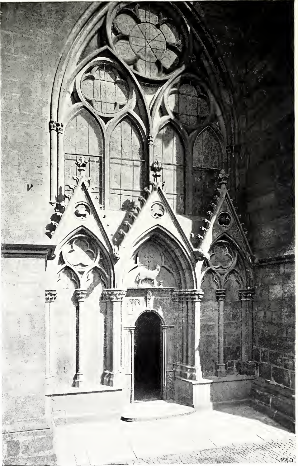
Portal des südlichen Seitenschiffes.
